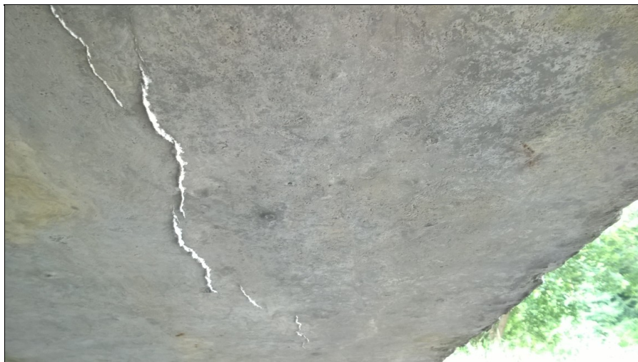
Trhliny v pohledu nosníků
