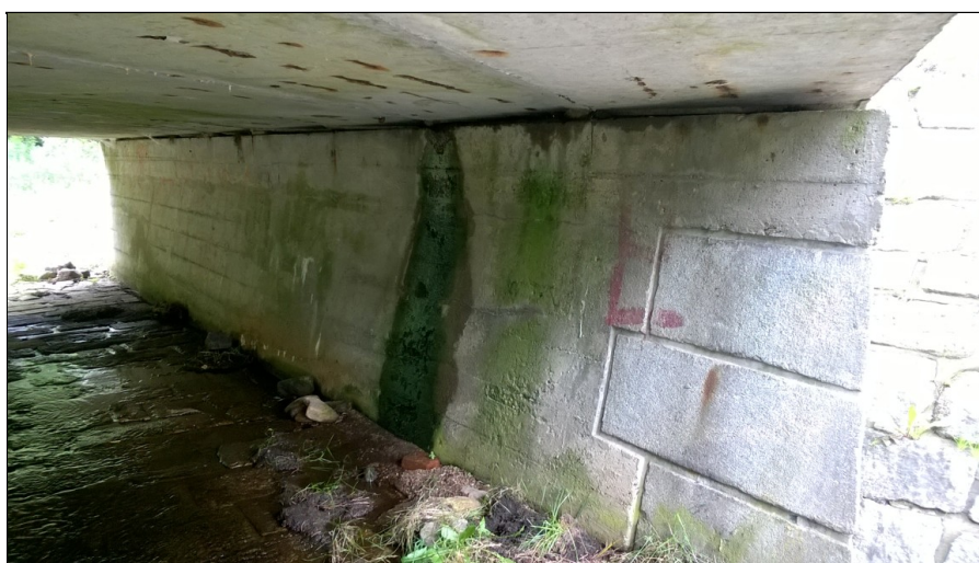
Pohled na líc pravobřežní opěry a podhled NK
