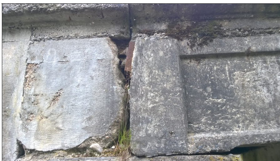
Viditelná povrchově zkorodovaná kotva předpětí na výtoku vlevo
